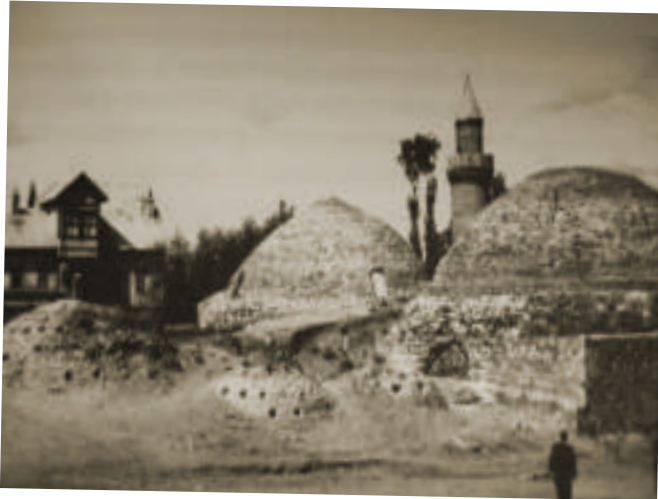
Boyahane Hamamı eski hali.
